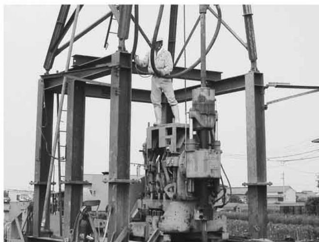
平成17年に渇水対応の深井戸を掘削（飯山町）
