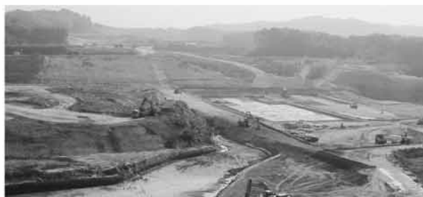
香川用水調整池の建設工事現場を視察（三豊市）
