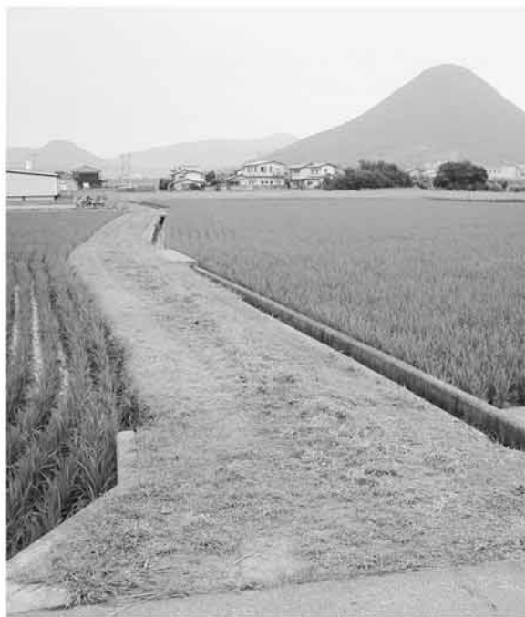
適正な維持管理が望まれる農道・水路
