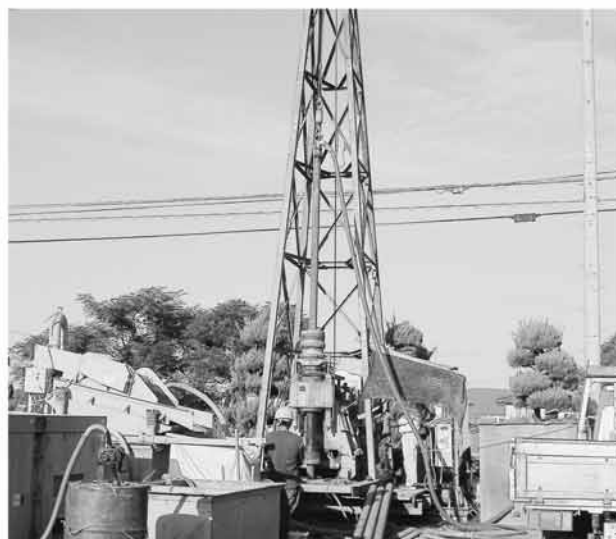
渇水対策のために深井戸を掘削（金倉町）
