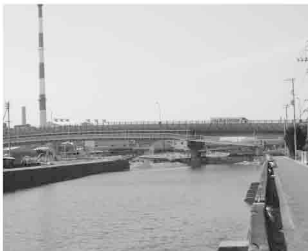
平成24年度に撤去予定の富士見大橋
