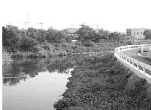
西汐入川の塩屋橋南側の護岸整備
