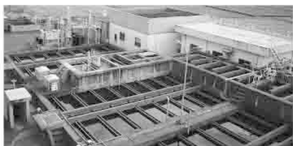
大切な水を供給します（垂水浄水場）
