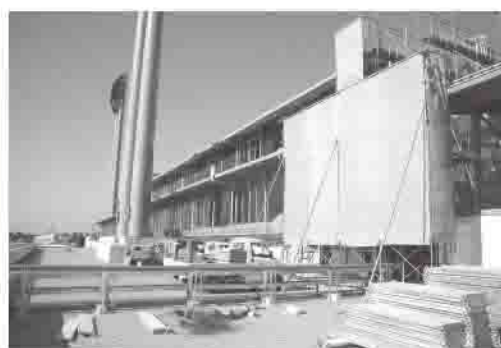
改築工事中の丸亀ボート場
