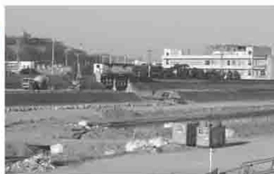
土器川（城東小学校付近）の工事
