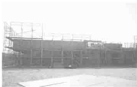
建設工事が進む新塩屋保育所
