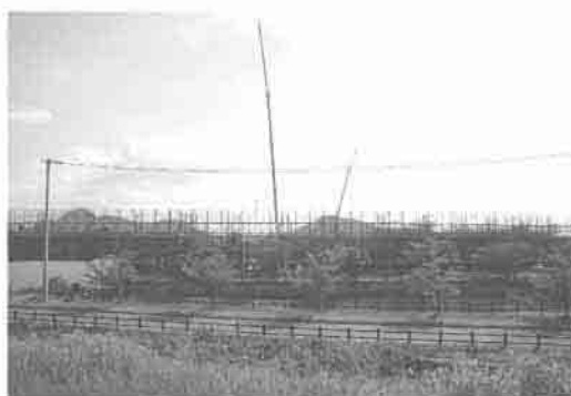
建設の進む野球場
