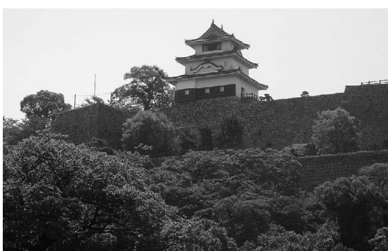
石垣修復が進む丸亀城
