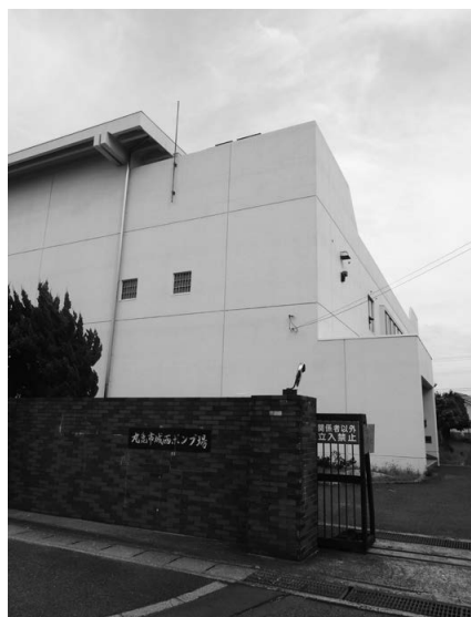
城西ポンプ場
