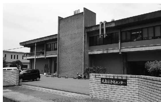
建て替え予定の市浄化センター
