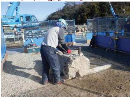
②壊れた石材の代わりに新しく石材製作します
