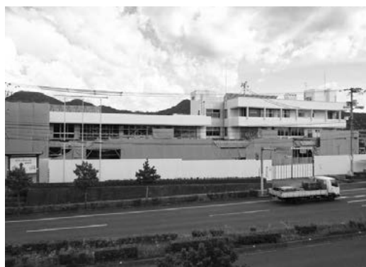
9月中旬の業務開始に向け工事が進められています
