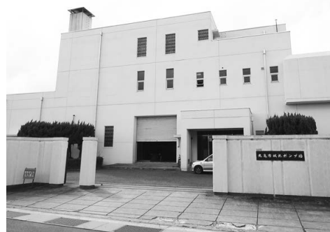
城北ポンプ場（富士見町）
