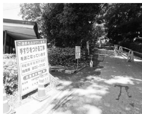
見返り坂に手すりを設置しています
