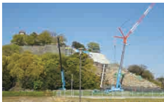
丸亀城石垣復旧工事
