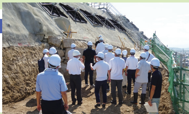
掘削調査現場での視察研修
