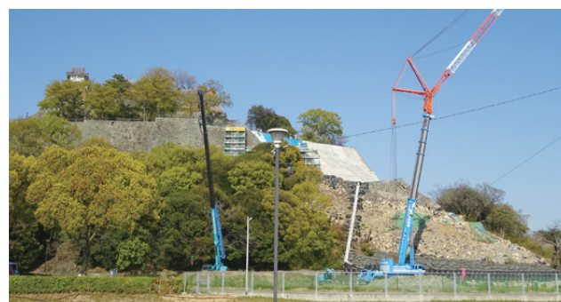
丸亀城石垣復旧工事
