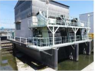
産砂ポンプ場の外観
