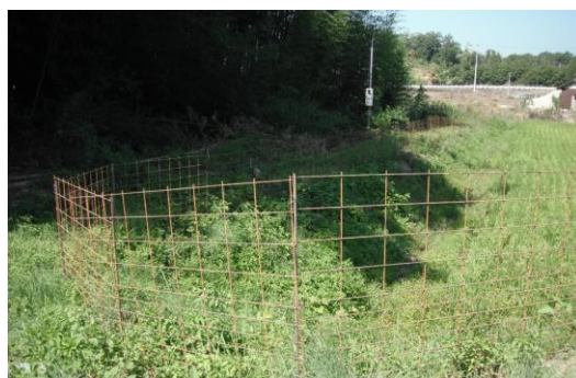
侵入防止柵の設置
