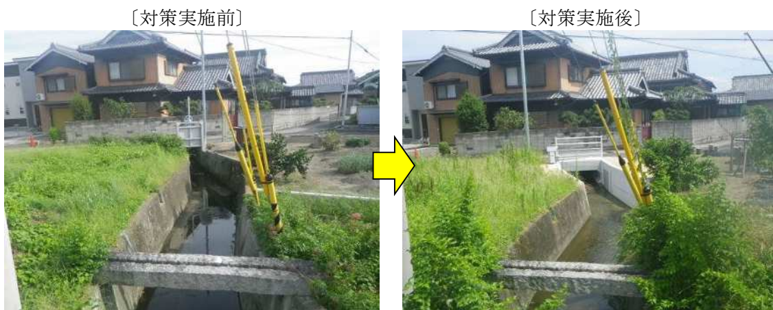
既設水路の拡幅工事
