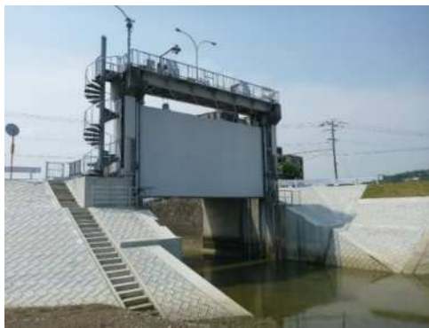
逆流防止のための水門（清水川水門）
