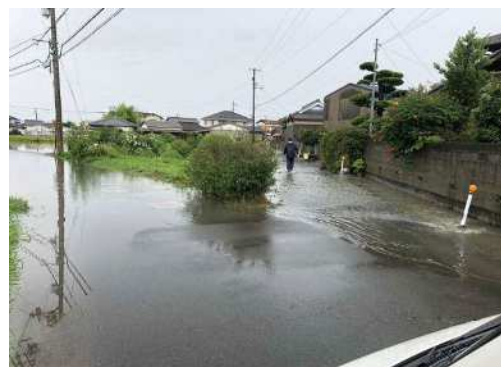
郡家町の道路浸水 （令和3年7月洪水）
