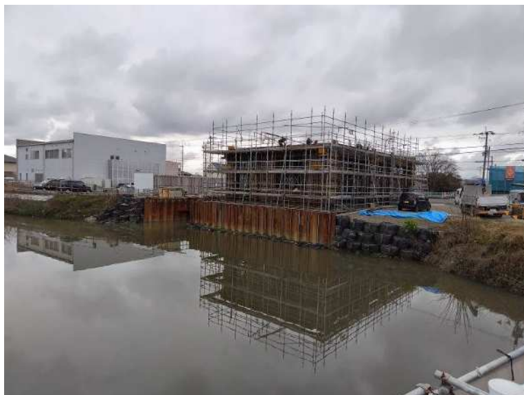
図 5.2.4 整備中の今津ポンプ場（令和 6 年 2 月撮影）
