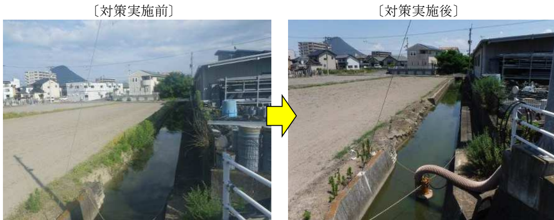
臨時排水ポンプの設置
