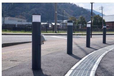
フットライト併設電源（敦賀市）
