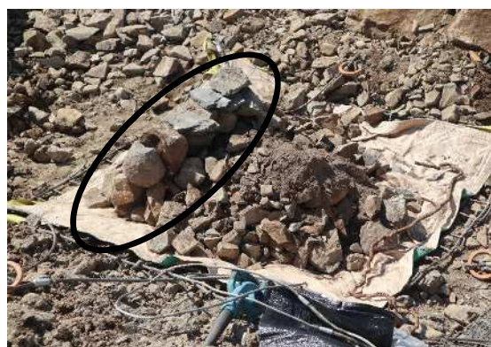
写真8 栗石による石積み
