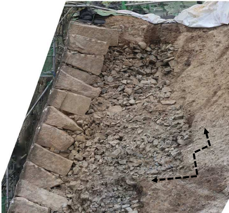
写真 5 三の丸西面石垣断面
