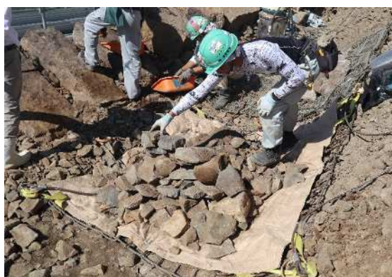
写真7 栗石積み込み作業
