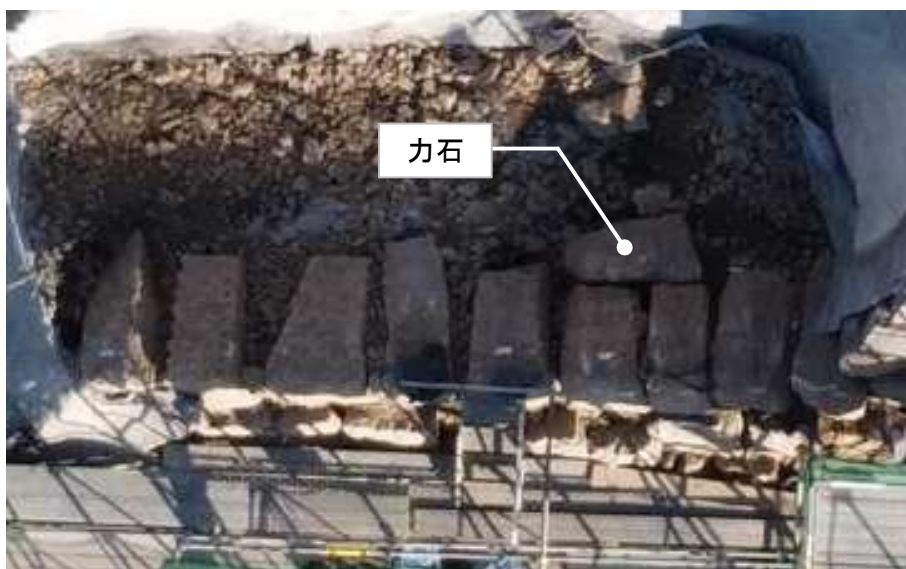
石材回収及び石垣解体時に確認された力石
