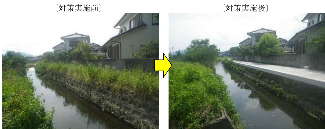
飯野町赤山川上流の護岸嵩上げ工事
