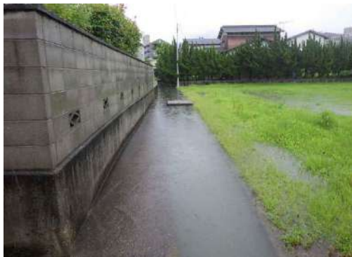
土器町東八丁目の水路の溢水 (令和3年7月洪水)
