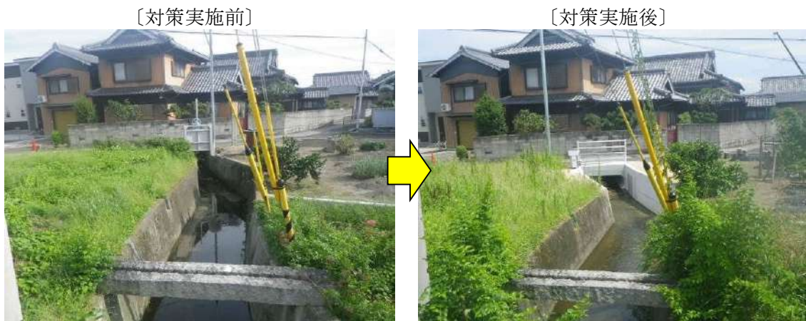
既設水路の拡幅工事
