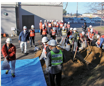
土のう作製の様子
