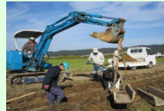
コンクリート水路の更新
