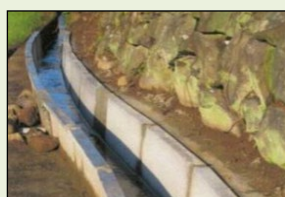
素堀り水路からの更新
