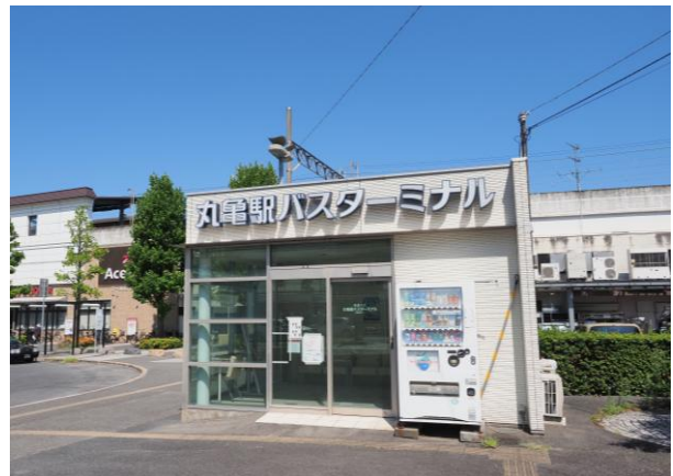
図 14 JR 丸亀駅の高速バス待合室
