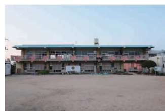
丸亀市立城坤幼稚園
