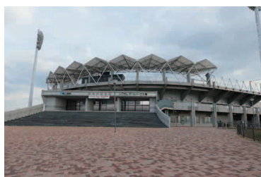
香川県立丸亀競技場
