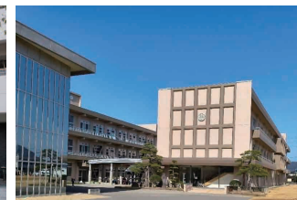
丸亀市立城坤小学校
