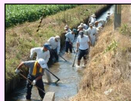
水路の泥上げ
