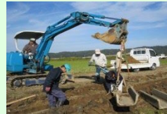
コンクリート水路の更新
