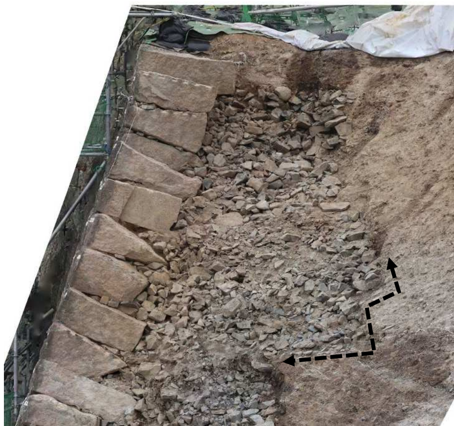
写真1 三の丸西面石垣断面
