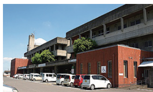
綾歌市民総合センター
