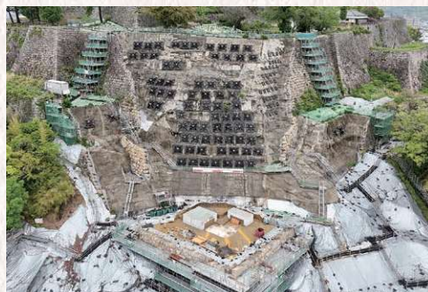
2026年 三の丸石垣根石保護工事
