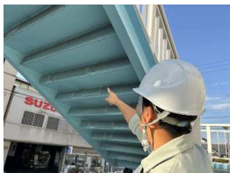
図 3. 1 定期点検の様子
