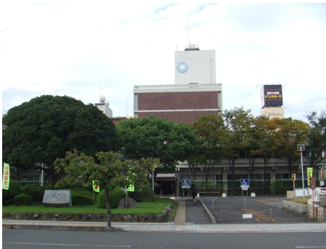
丸亀市役所(昭和 39 年竣工)
