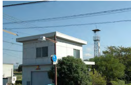
消防第五分団屯所
