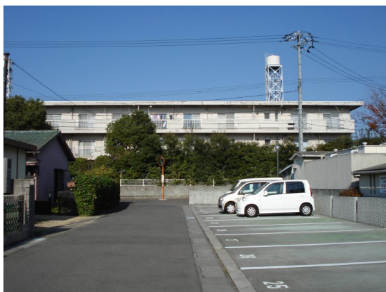
城東団地駐車場労災病院側
