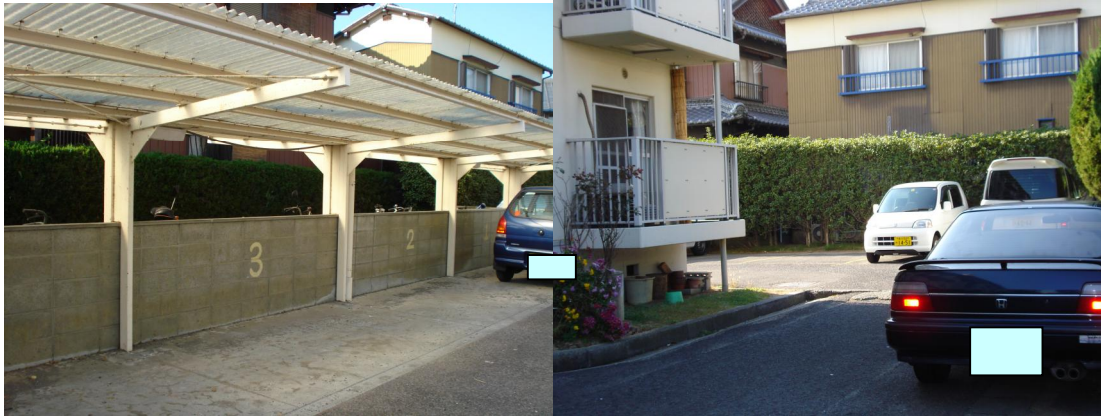
駐車場として使用されている駐輪場
