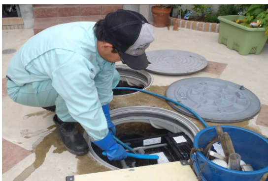
浄化槽の検査状況
