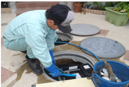
浄化槽の検査状況
