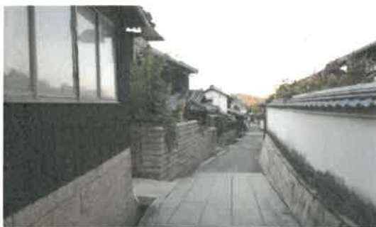
石材を用いた基礎や塀（本島）
