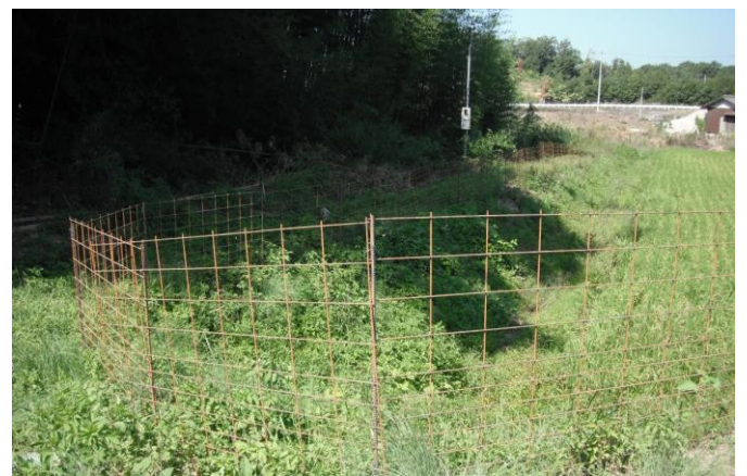
侵入防止柵の設置
