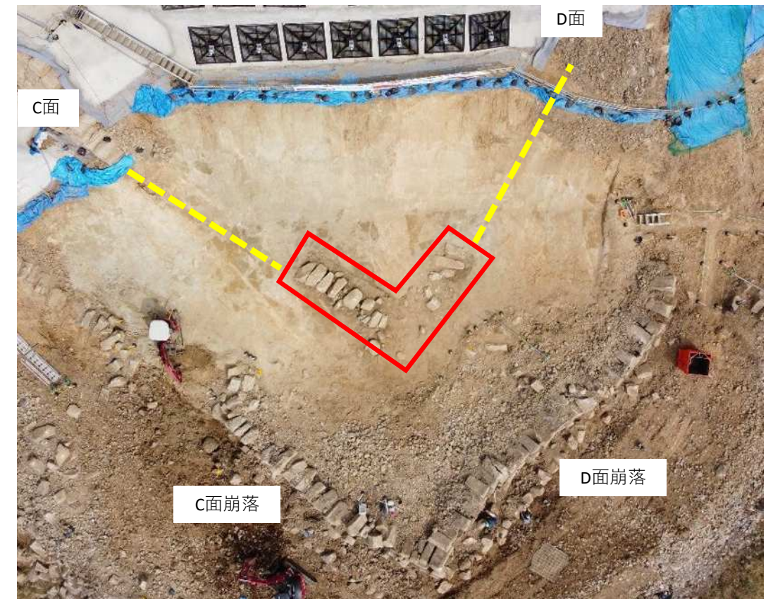
復旧工事現場を上空より撮影
