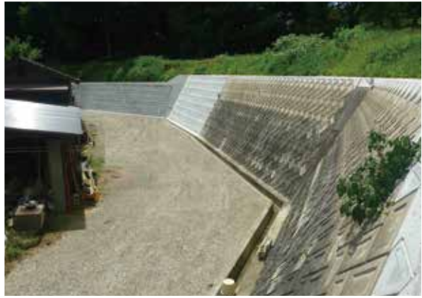
2 法面保護擁壁
