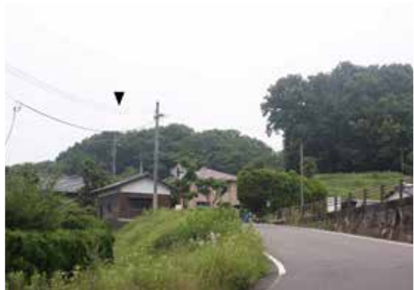
4 東側進入路 東より (約 226 m東)
