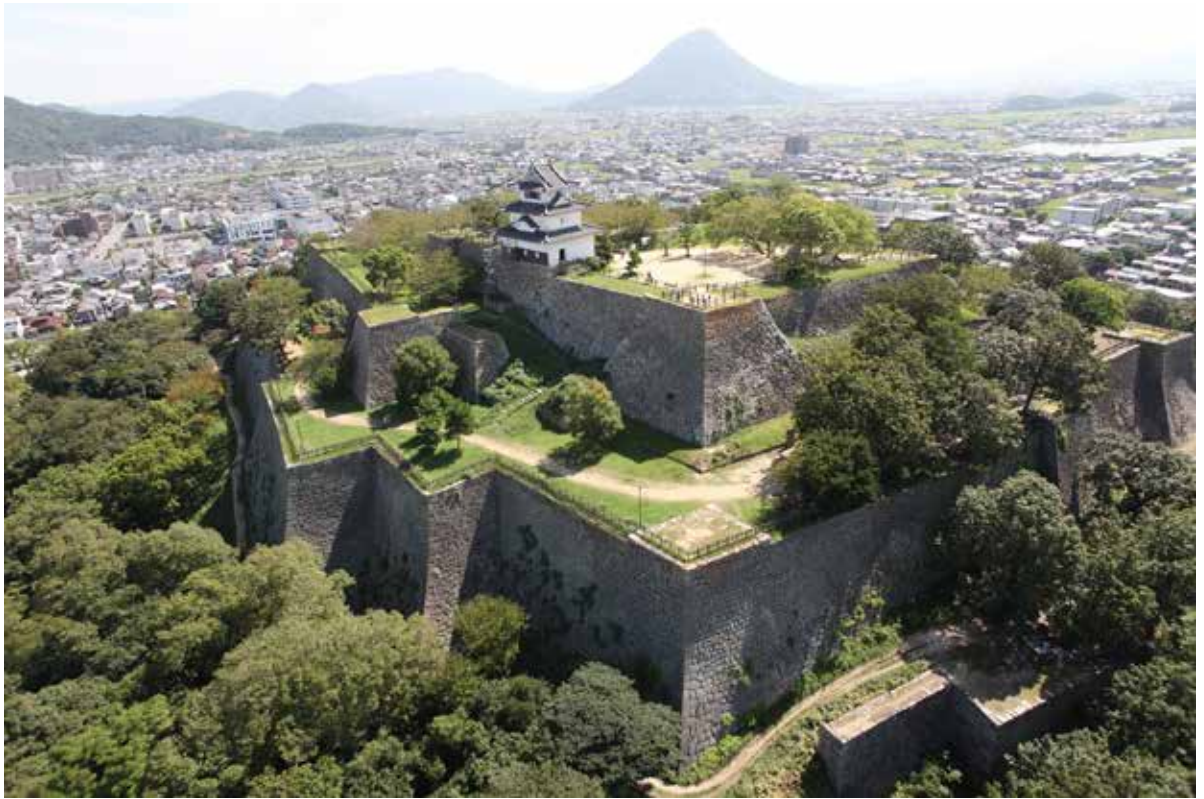
三段重層する石垣（北西から）
