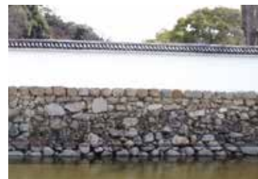
写真23 御殿跡北側の 野面積み石垣
