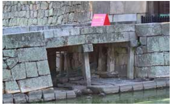
写真 14 陸軍により架けられた大手口の石橋
