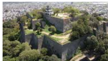
写真 19 丸亀城跡の石垣
