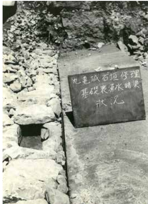
写真 38 石垣基礎裏暗きよ設置
