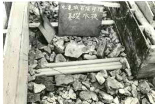
写真 40 基礎部の排水管設置
