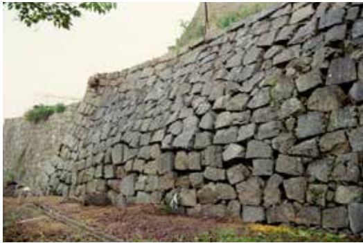
写真 55 帯曲輪南石垣修理前
