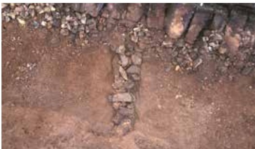
写真 60 帯曲輪石垣に向かう盛土中の排水施設
