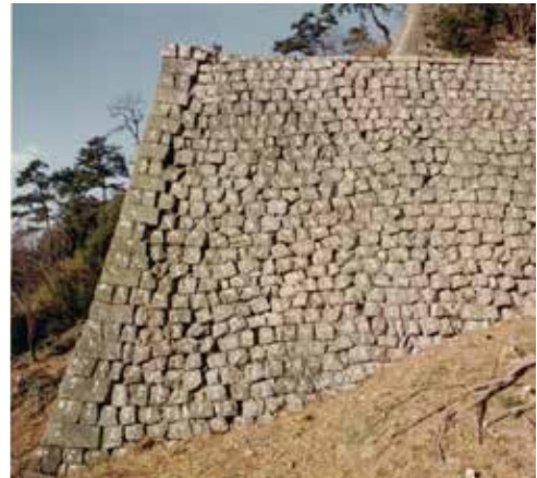
写真 42 帯曲輪南側石垣南側修理前
