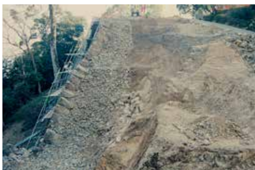
写真 64 石材取り外し後 北から
