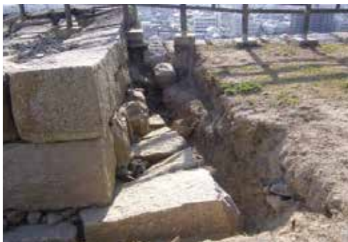
写真 73 坤櫓台石垣嵩上げを伴う 改修痕
