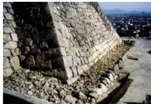
写真 74 西側高石垣基部を補強するた めとみられる埋没石垣
