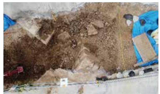
写真 86 埋没石垣間の盛土中の栗石 (真上から)
