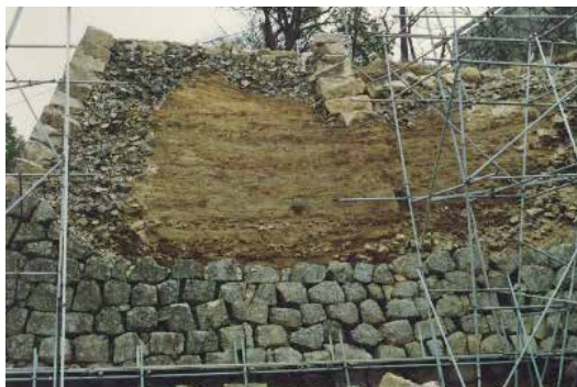
写真 49 石垣の内部構造
