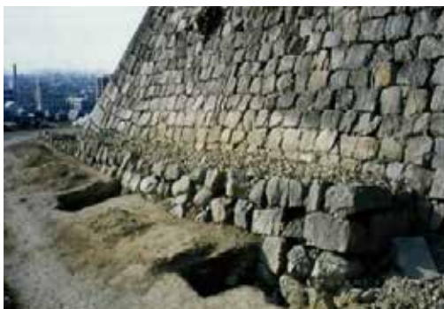
写真 75 南側高石垣の基部を補強する ためとみられる埋没石垣
