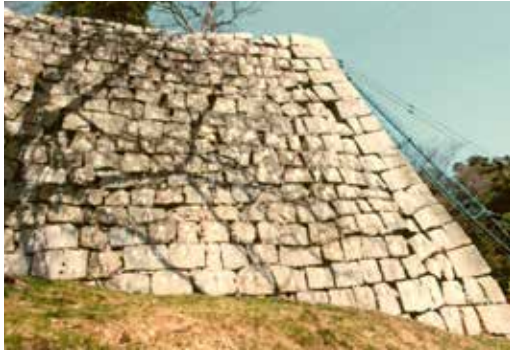
写真 35 搦手門東南方石垣西側修理前
