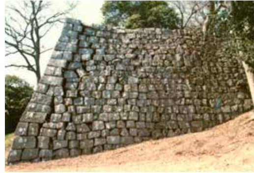
写真 36 搦手門東南方石垣東側修理前
