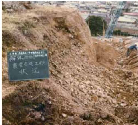
写真 43 石垣背面の盛土と栗石検出
