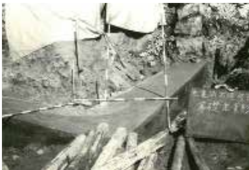
写真 39 石垣基礎コンクリート打設
