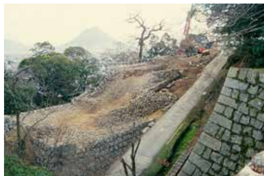
写真 63 石材取り外し後 西から
