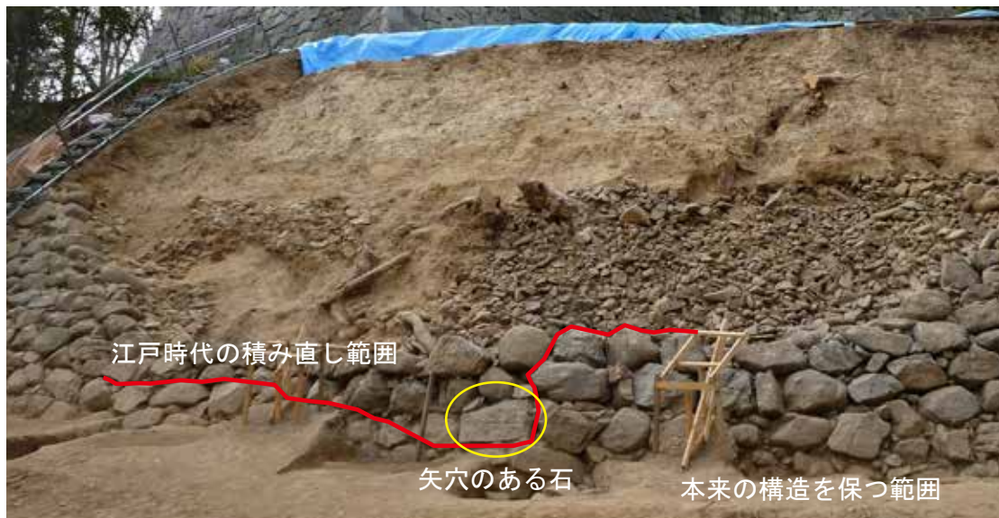
写真 69 石材の取り外し後
