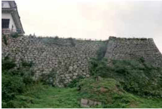
写真 51 本丸北石垣修理前
