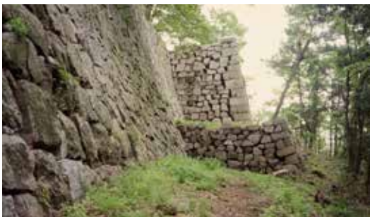
写真 58 帯曲輪西石垣修理前
