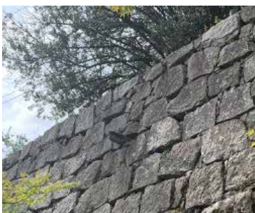
⑲石樋の排水口
