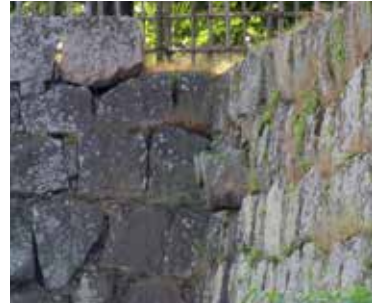
⑨石樋の排水口
