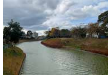
③南側 堀の肩口が土塁
