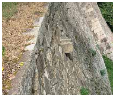
⑳石樋の排水口
