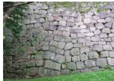
③⑩二の丸南側 拡張した石垣
