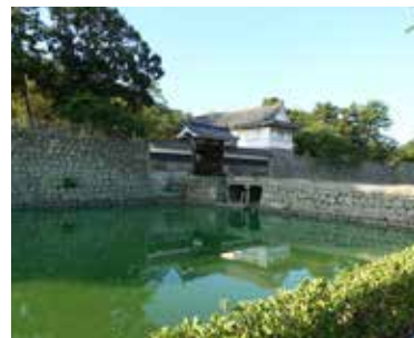
⑮大手口土橋 (石垣護岸)
