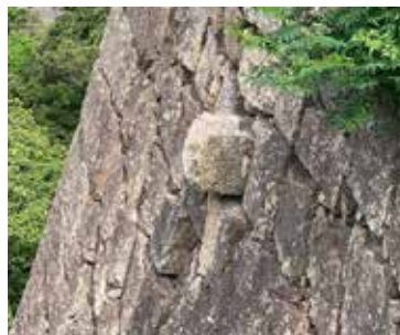
⑰石樋の排水口
