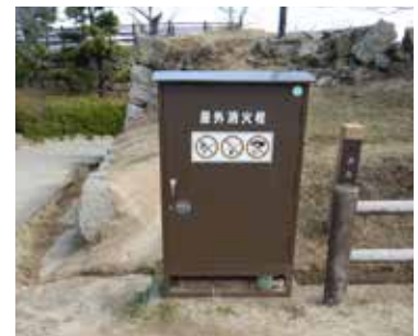
③ 防火施設
