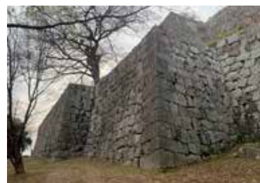
③⑥帯曲輪南側 補強石垣 (左奥)
