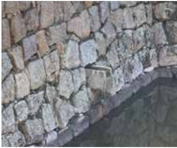
⑦石樋の排水口
