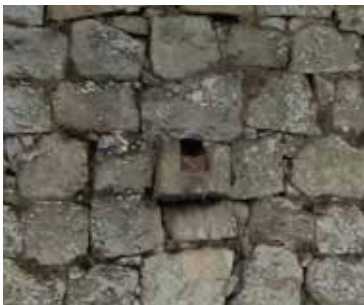
⑩石樋の排水口
