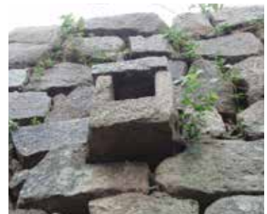
⑱石樋の排水口
