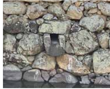
⑥石樋の排水口
