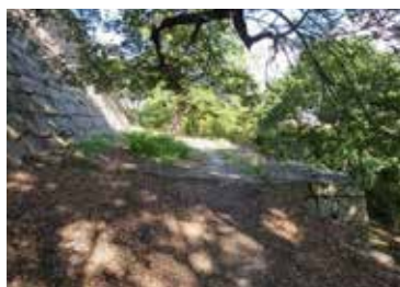
③⑤玉槽下の帯曲輪に築かれた 補強石垣
