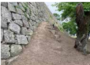
③④二の丸番頭櫓跡北側 補強石垣
