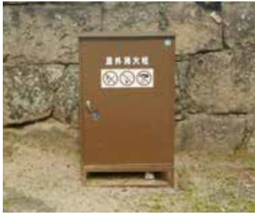
④防火施設
