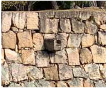
⑧石樋の排水口
