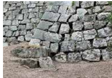
③③二の丸番頭櫓跡隅角部 補強石垣
