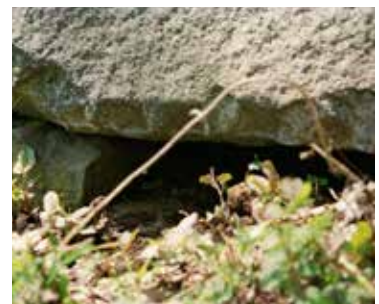
㉑石垣基部の排水口
