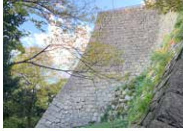
②③三の丸北側石垣 扇の勾配
