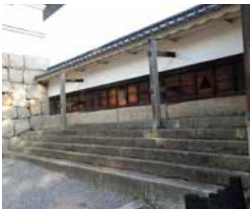
⑬石段 (雁木遺構)
