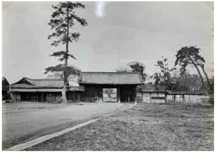
玄関先御門 昭和43年(1968)頃 南から 玄関先御門修理前の写真帳より 丸亀市蔵
