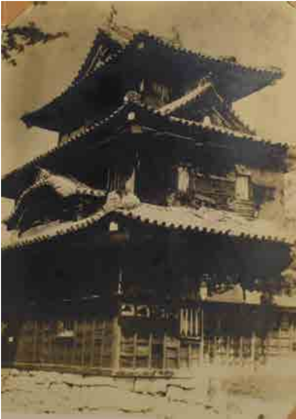
丸亀城天守 昭和 20 ~ 23 年 (1945 ~ 1948) 南東から 天守修理工事写真帳より 丸亀市立図書館蔵
