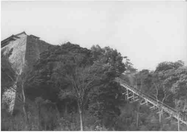
三の丸東面にあった上水道送水管 (大正 15 年設置、平成 5 年撤去) 南東から 丸亀市教育委員会蔵
