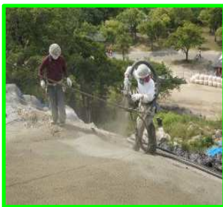
【モルタル吹付と崩落石回収の様子】
