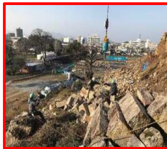
【モルタル吹付と崩落石回収の様子】
