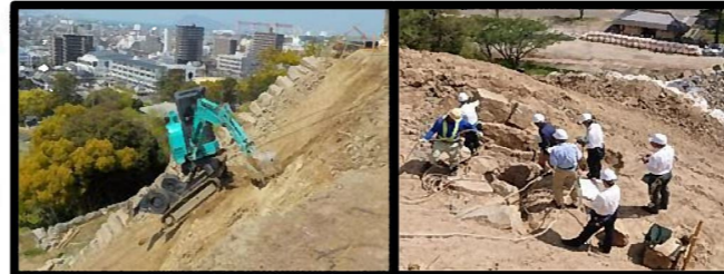
【ロッククライミングマシンによる斜面掘削】
